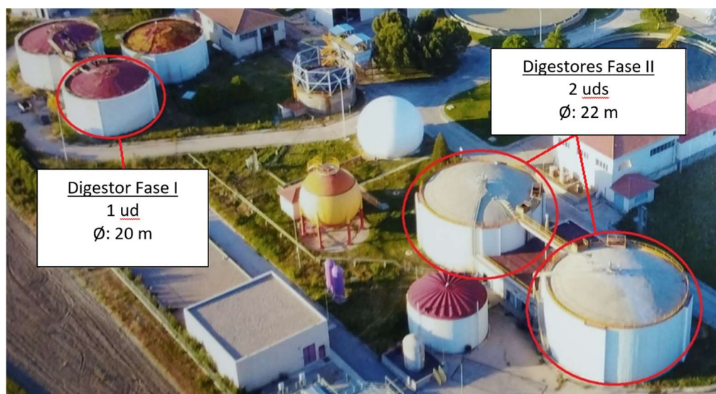
Foto 11. Digestores a calorifugar existentes en la EDAR
