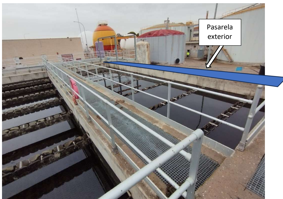
Foto 9. Nueva pasarela en Decantador lamelar
