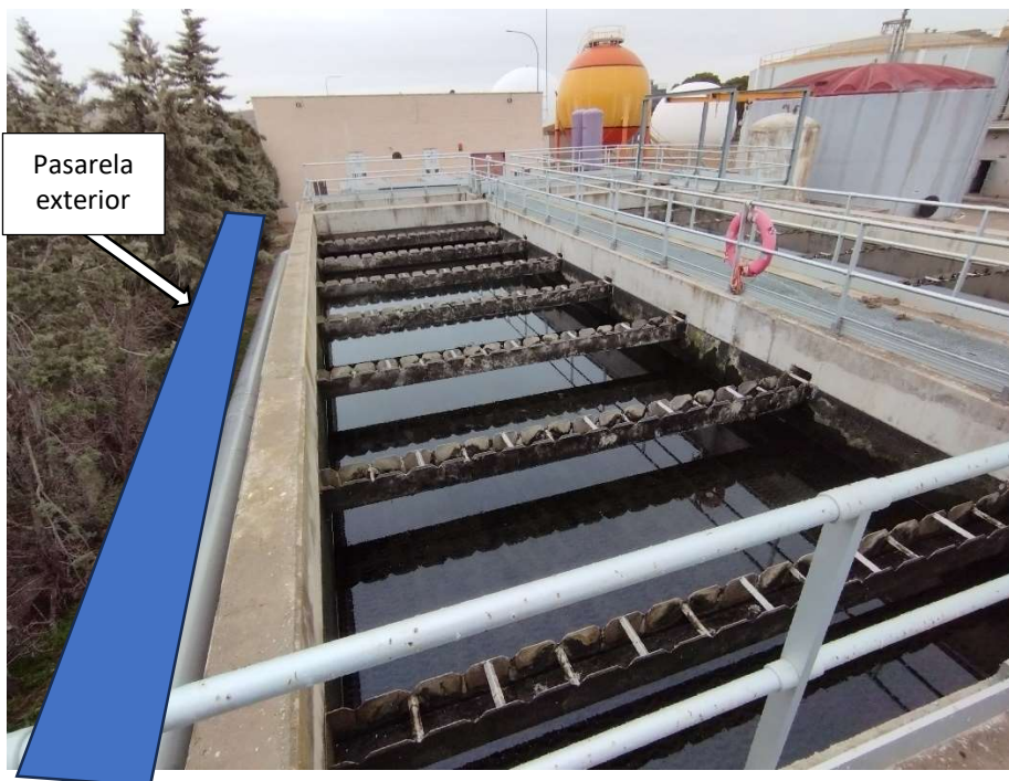
Foto 8. Nueva pasarela en Decantador lamelar
