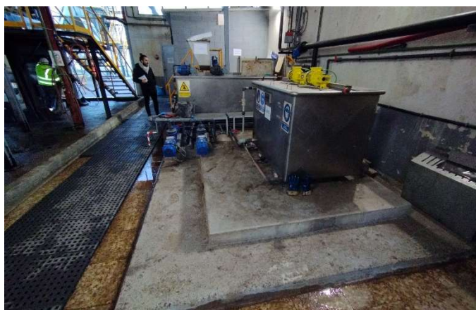
Foto 4. Instalación existente de equipos de polielectrolito
