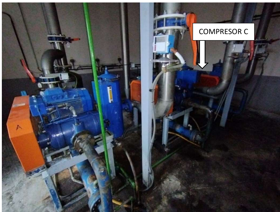
Foto 1. Instalación de compresores de biogás existentes
