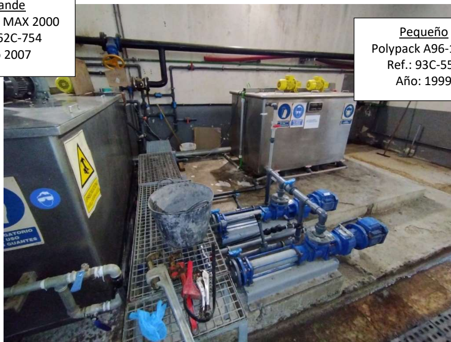
Foto 5. Instalación existente de equipos de polielectrolito
