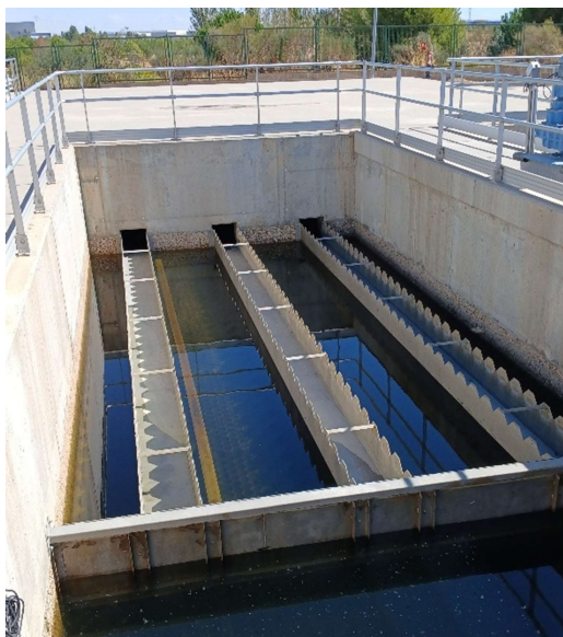
Decantador lamelar en tratamiento terciario existente
